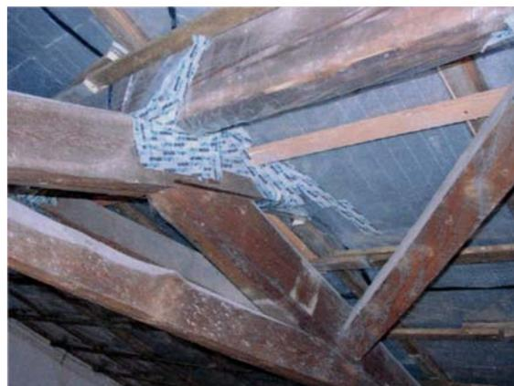
**Durchdringungen der luftdichtenden Ebene im Dach müssen mit hohem Aufwand dauerhaft abgedichtet werden**
