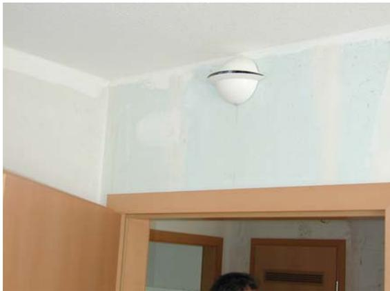
**Zuluftventil (Weitwurfdüse) über einer Innentür**
