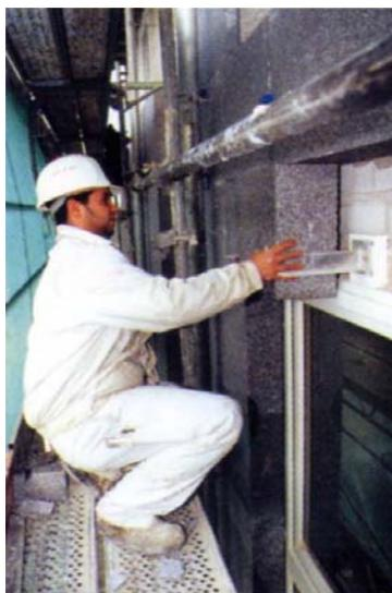
**Montage des Wärmedämmverbundsystems:** Erkennbar ist eine der punktuellen Verankerungen des vorgeständerten Balkons
